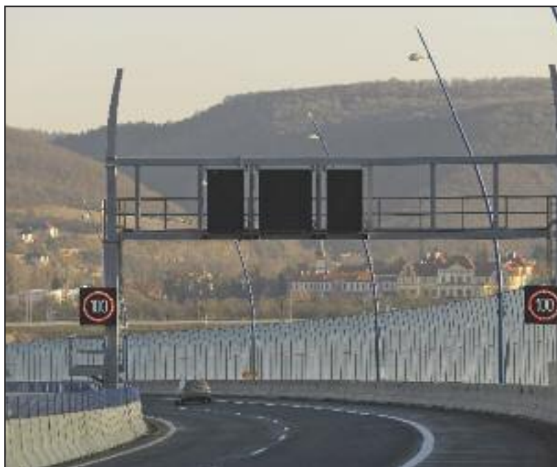
Portál LŘD ve zkušebním provozu
