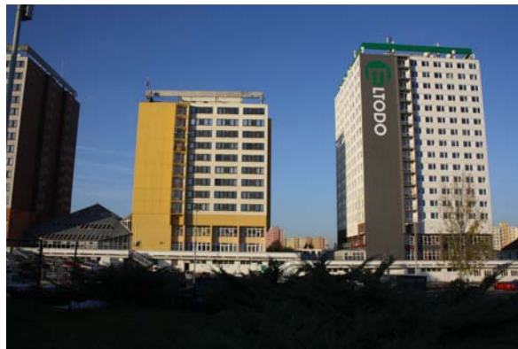
Recepce budovy A
