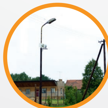
Soustava VO před rekonstrukcí
